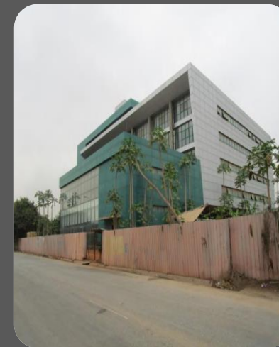
Edifício Data Center
